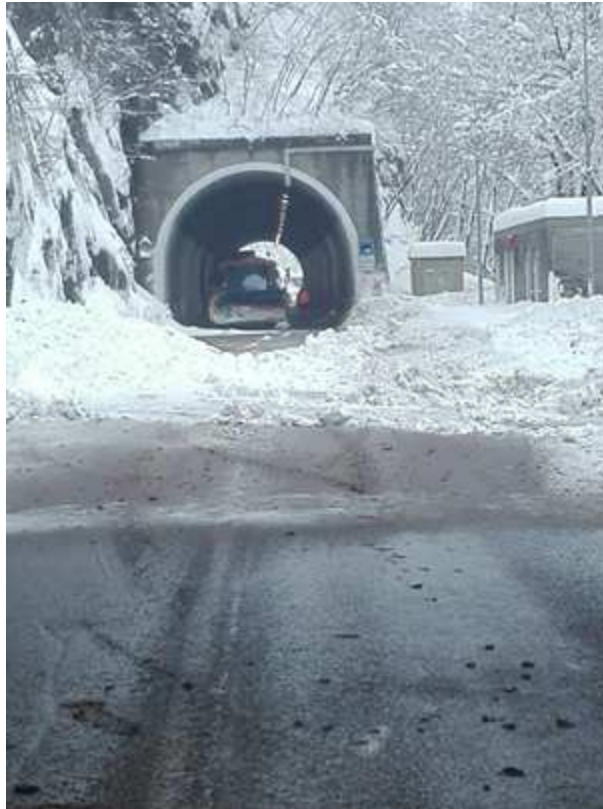
Fig 14. Valanga del 2 gennaio sulla SS 237 in località Ponte Pià.
