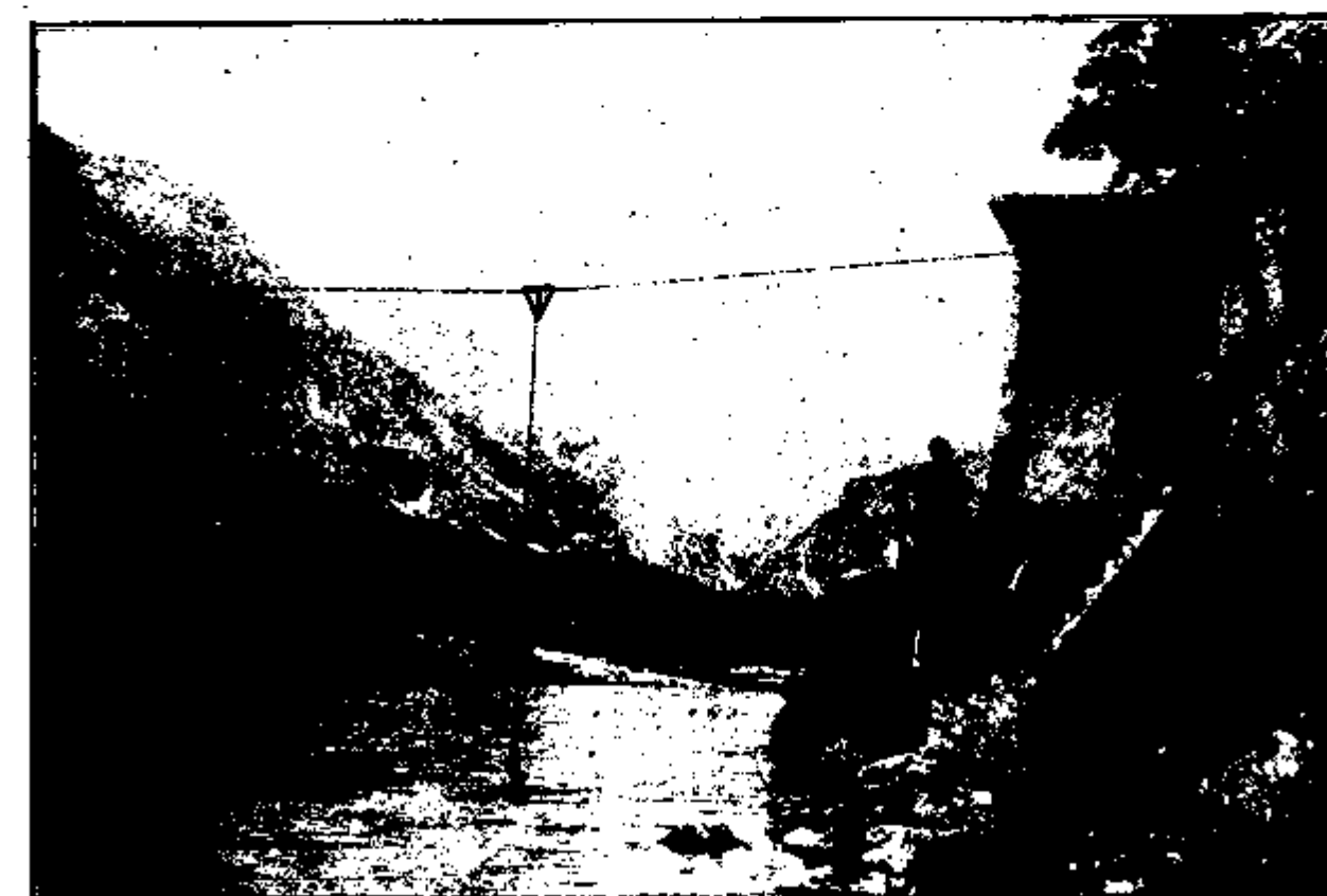
FIG. 62 - Stazione per la misura delle portate dell'Isonzo a Saga. Vista della teleferica manovrabile dalla sponda sinistra.
